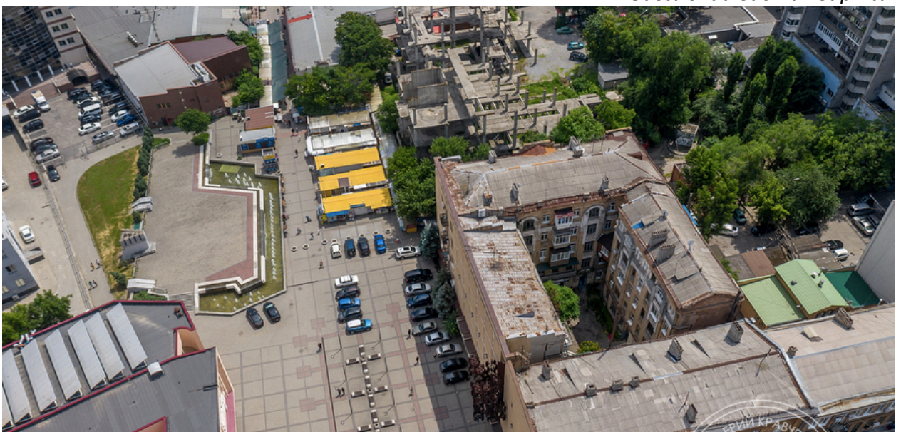
Загальний вид на квартал
